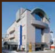
高井田メモリアルホール 東大阪市高井田本通3-1-31
